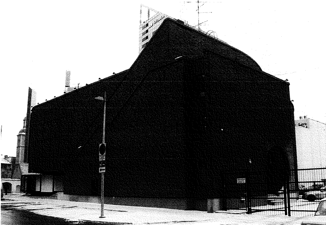
7.2. Vaade Viiralti tn-lt hoone tagafassaadile.
