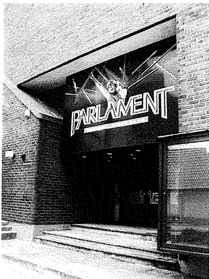
7.3. Tartu mnt. poolne sissepääs
